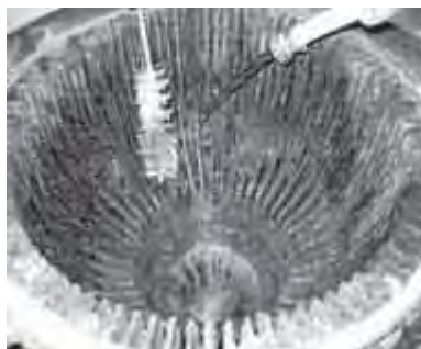
Fig. 9-14 Nettoyage de la chambre de combustion avec un tuyau d'eau
